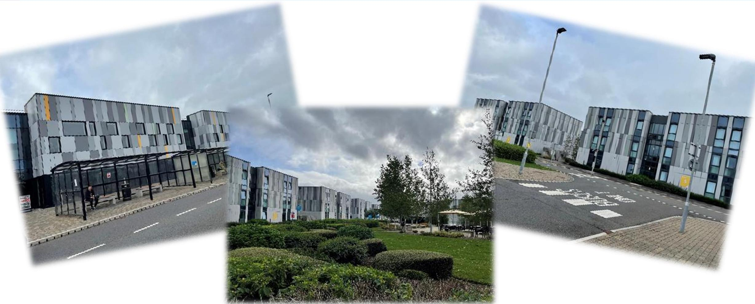
29 blocs de 34 modules préfabriqués en usine et assemblés sur place – 700 places de parking
